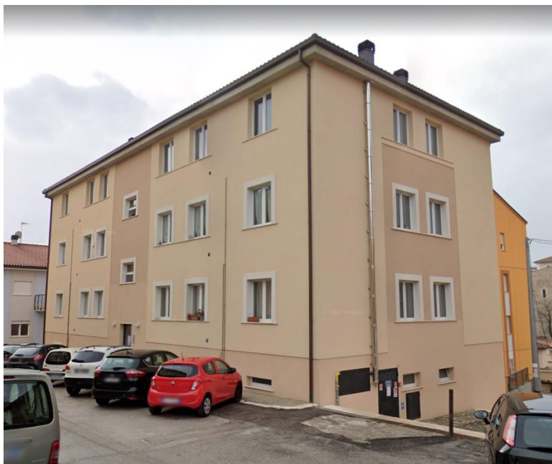
Fabbricato ATER 392 anno 2023
